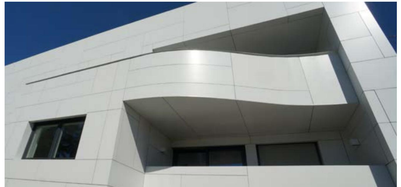
I pannelli compositi di haushaut sono ideali per il rivestimento di facciate inconfondibili e molto esigenti. Offrono tutti i vantaggi di un pannello composito in alluminio, dall'eccellente plasmabilità all'ottimo rapporto peso/rigidità flessionale, nonché un'estrema planarità. La resistenza alla corrosione consente una fondamentale flessibilità del design e garantisce prestazioni durevoli.
