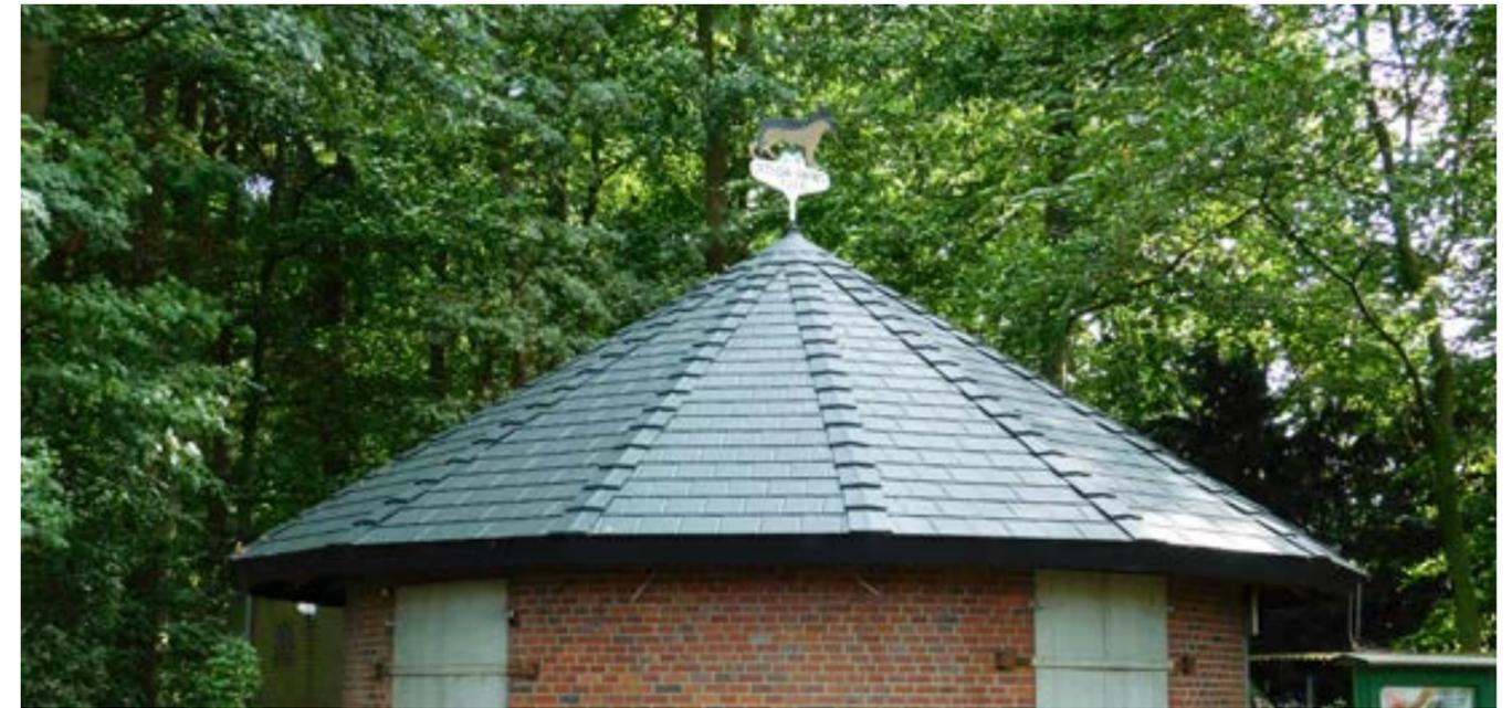
La scandola Canadese è in alluminio con rivestimento preverniciato e, per ogni progetto, forma una copertura resistente alle intemperie. Le scandole sono di piccolo formato, quindi ottimali per personalizzare la configurazione su tetto e facciata. I nostri clienti utilizzano con piacere questo prodotto soprattutto per il rivestimento di timpani, abbaini, camini e grondaie.
