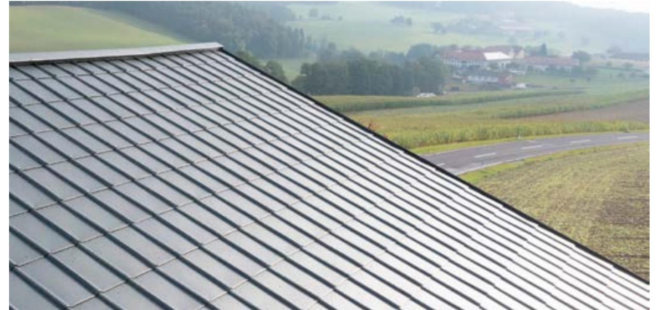
La tegola in alluminio Starry può essere posata già a partire da una pendenza del tetto di 12 gradi. La superficie è antiriflettente e "mimetizza" le irregolarità estetiche. Unisce inoltre l'immagine classica di un tetto del passato con i vantaggi dati da leggerezza, durata e sicurezza contro le tempeste del tetto in alluminio Starry.
