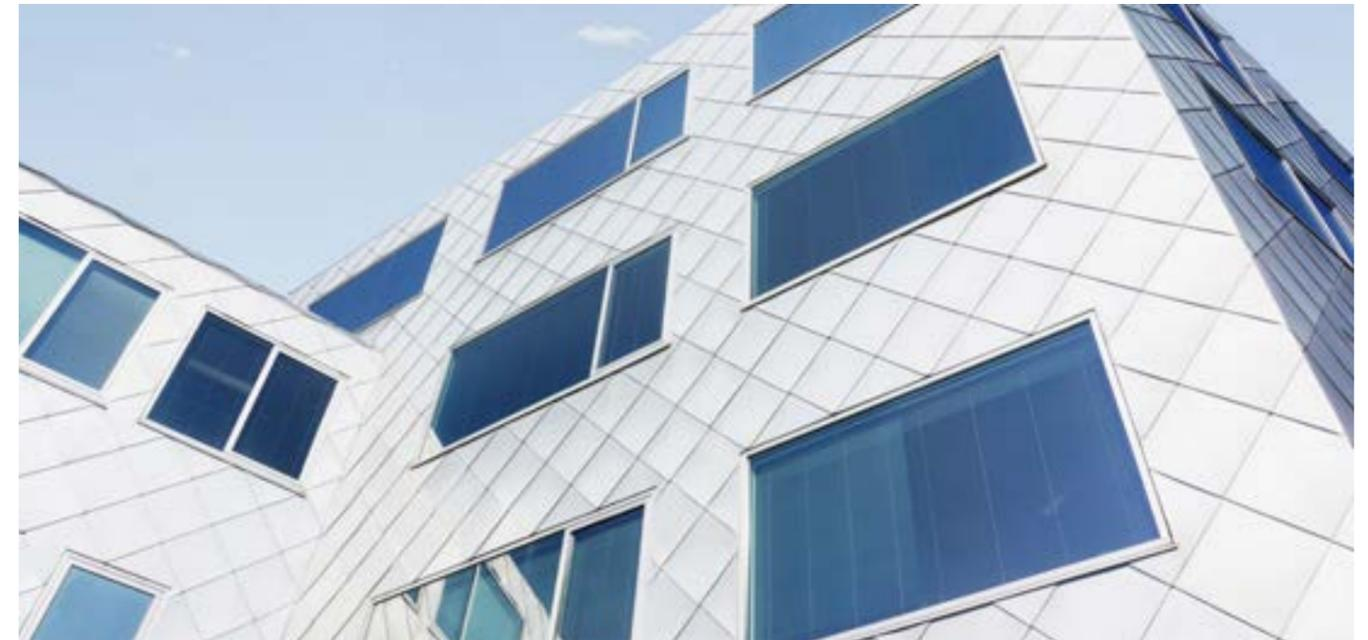
La scandola quadrata garantisce una copertura dell'edificio priva di manutenzione e in grado di proteggere dalle intemperie. Le scandole in alluminio, in presenza di una pendenza del tetto di 25°, sono ottimali per la copertura dell'edificio e donano inoltre un'immagine unica. Tutti i pezzi possono essere prodotti e forniti con un aspetto estetico personalizzato.
